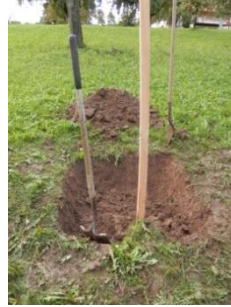
Pflanzgrube ca.30cm tief ausheben
